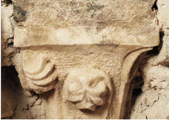
24. Capitello à crochet , bifora di facciata, fine del XIII secolo-primotrentennio del XIV, già chiesa di San Francesco, oggi palazzo San Francesco, Domodossola
